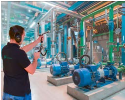
Punktgenaue Leckageortung im laufenden Betrieb mit Laserpointer und integrierter Kamera
