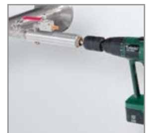
Anbohren unter Druck mit der CS Bohrvorrichtung
